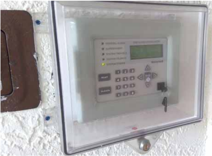
Condo Bldg Fire Alarm Annunciator
